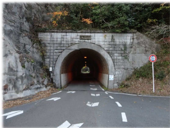
塔ノ峠トンネル
