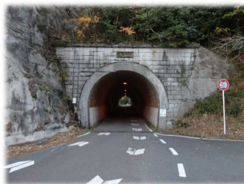
塔ノ峠トンネル
