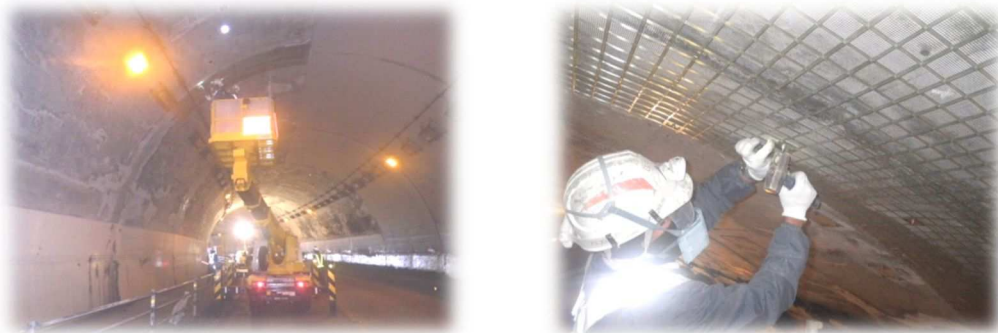
写真 3-1 FRP ネット設置状況
