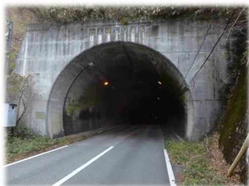
唐人屋トンネル
