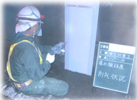
写真 3-2 線導水工
