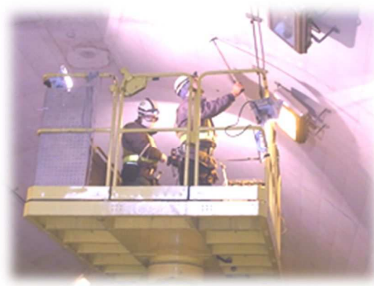
写真 2-1 トンネル点検状況
