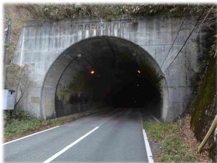
唐人屋トンネル
