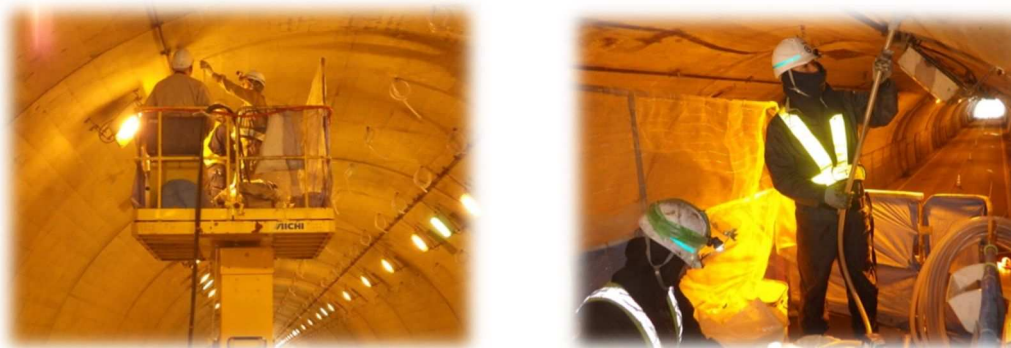
写真 3-4 裏込注入状況
