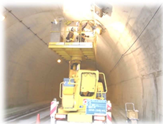
写真 2-1 トンネル点検状況
