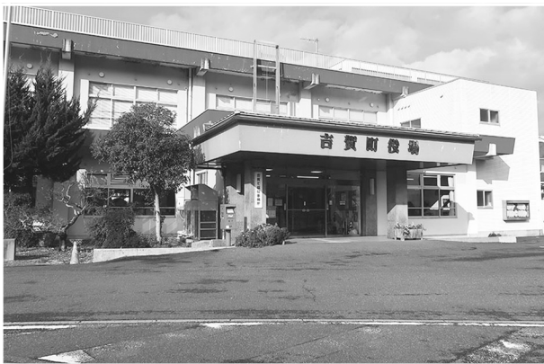
庁舎非常用発電機更新工事費 4,053 万円
