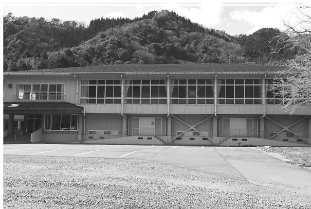
改修工事費 (蔵木小体育館トイレ洋式化等) 194 万円
