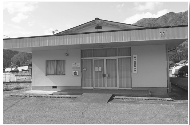
野中集会所エアコン更新工事費 165 万円
