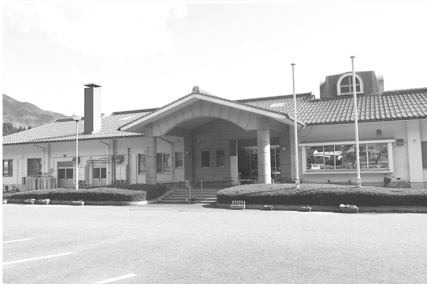
ぎんなん寮キュービクル式 受電設備増設工事費 2,119 万円
