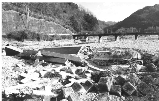
11月2日の大雨で被災した馬橋と平田頭首工
