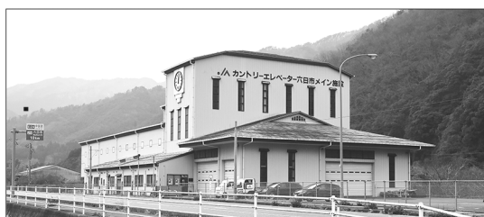
カントリーエレベーター
