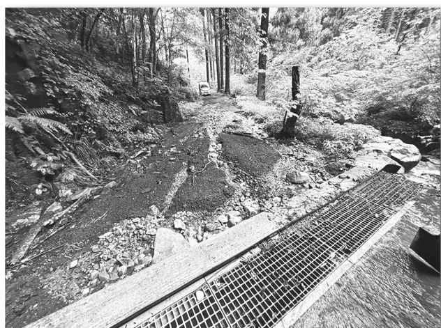
災害復旧工事費 林道 2,000万円
