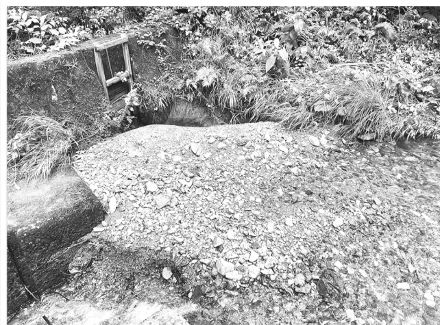
災害復旧工事費 農業用施設 2,740万円
