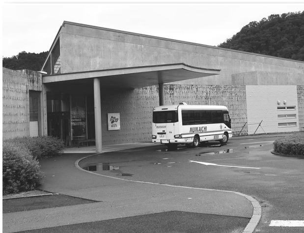
むいかいち温泉ゆ・ら・ら 浴室手すり修繕費 209万円
