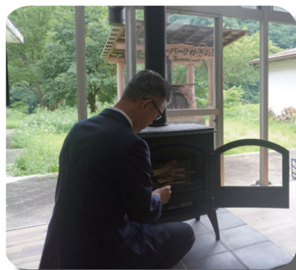
<薪ストーブ火入れの様子>
